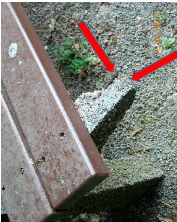
vorstehende Beton-/Stahlteile an Bänken - verdrehte Sitzauflagen
