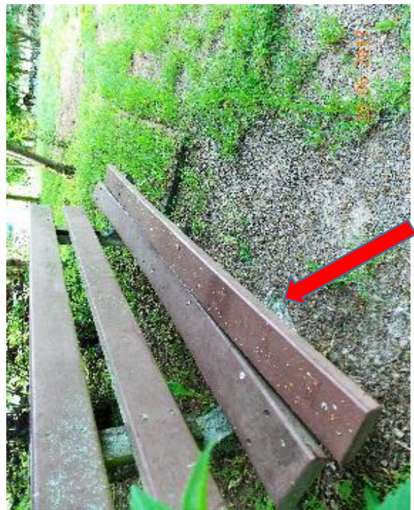
vorstehende Beton-/Stahlteile an Bänken - verdrehte Sitzauflagen
